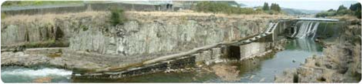
下流左岸より見た神子轟の瀬及び神子堰（中央の階段状の構造物は魚道）
